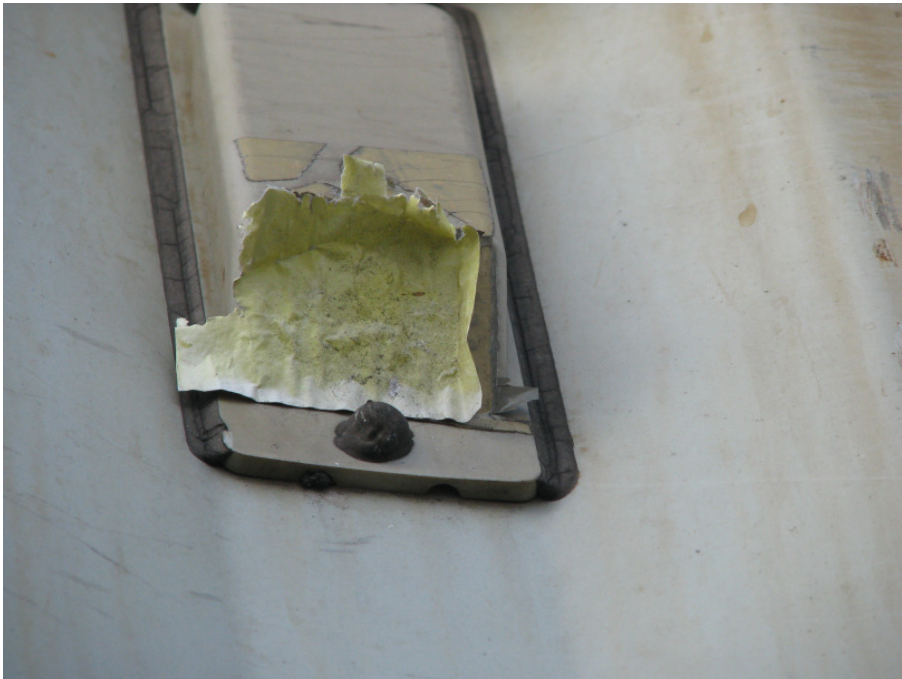
Abbildung 1: Lüftungsschlitze zugeklebt
