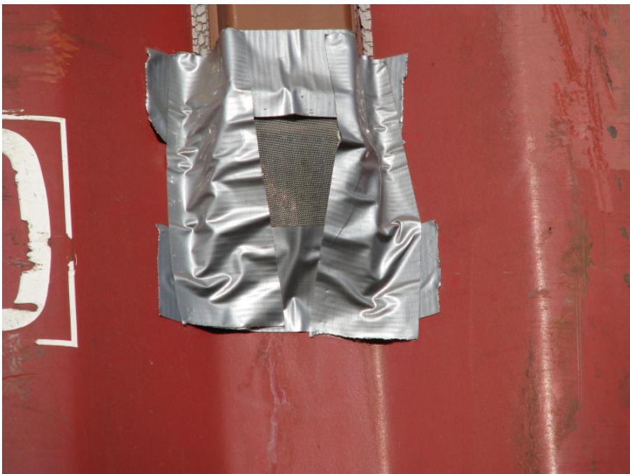
Abbildung 3: Lüftungsschlitze zugeklebt
